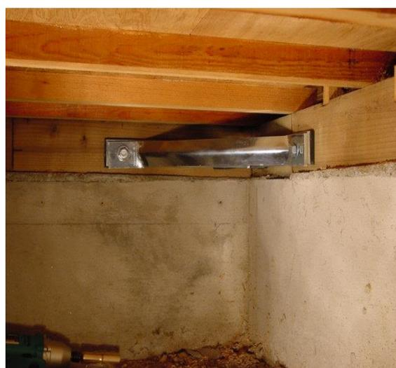
土台の隅角部に入れる斜材の火打ち土台が無い場合、床の水平面が大きく変形しネジレを起こす恐れがあります。
